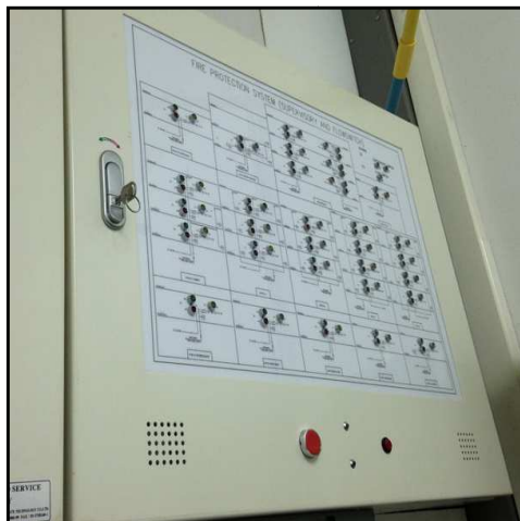
ภาพที่ 1-12 แผงควบคุม (Fire Alarm Control Panel) และแผงแสดงสัญญาณ (Annunciator Panel: ANN)
